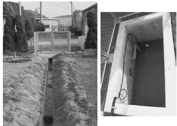
写真2 西圃場の排水整備 左：排水溝と貯水升（高さ1mの安全柵で囲む） 右：貯水升の内部（自然排水・自動排水の両用）
