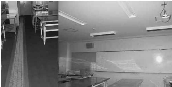
写真1 肉加工室内部の様子 左：排水溝の改修 右：天井・照明の改修
