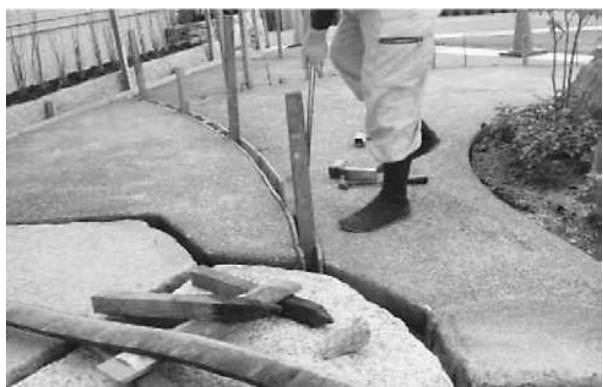
写真7 洗い出し舗装の型枠撤去
