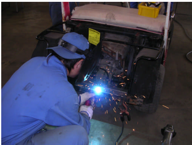
車体後部の補強とフック取付
